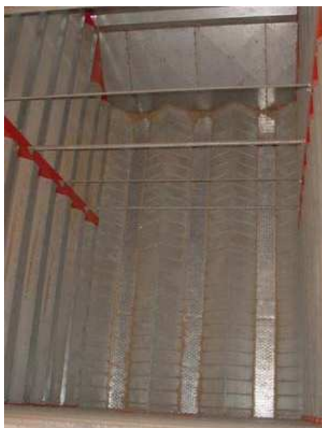
Silo fini de vidanger
