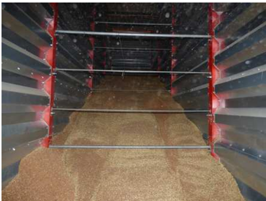
Silo en cours de vidange par la ventilation
